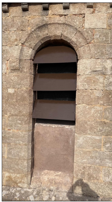
Les pare sons entièrement restaurés et repeints à l'identique. A l'intérieur, des grilles ont été posées pour empêcher les pigeons d'entrer.
