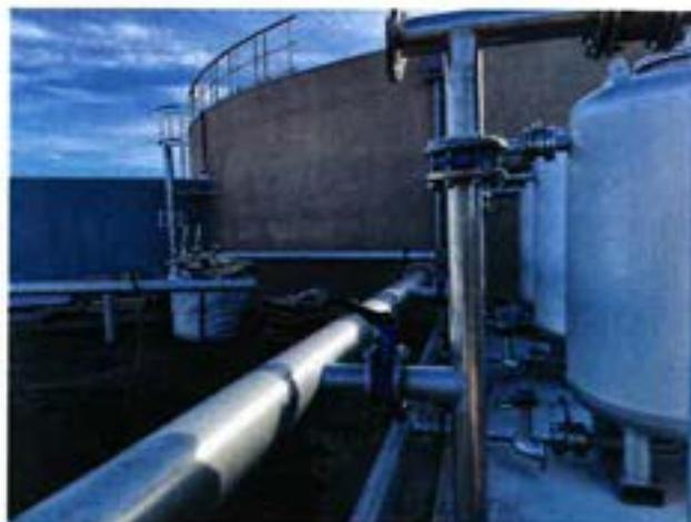
Raccordement des filtres au réservoir de St André-de-Sangonis.
